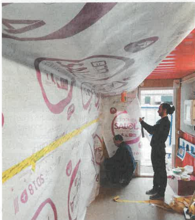
A Haubourdin, entreprises et maîtres d'œuvre ont posé de concert une membrane dans un conteneur installé sur le chantier.
