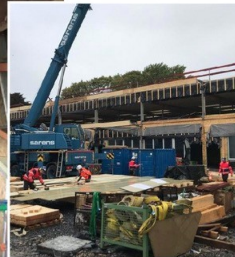
La future école Crapet-Salengro (12 M€) est à ossature bois. Les écoliers y entreront en septembre 2020.
